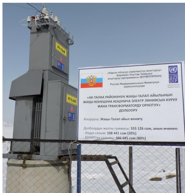
Новая трансформаторная подстанция
